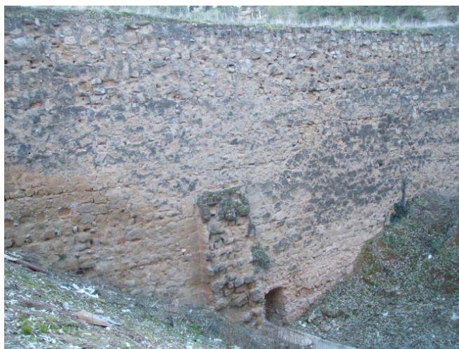
Imatge 2. Tram de muralla del s. XIV al barranc del torrent amb restes d'un element antic.
