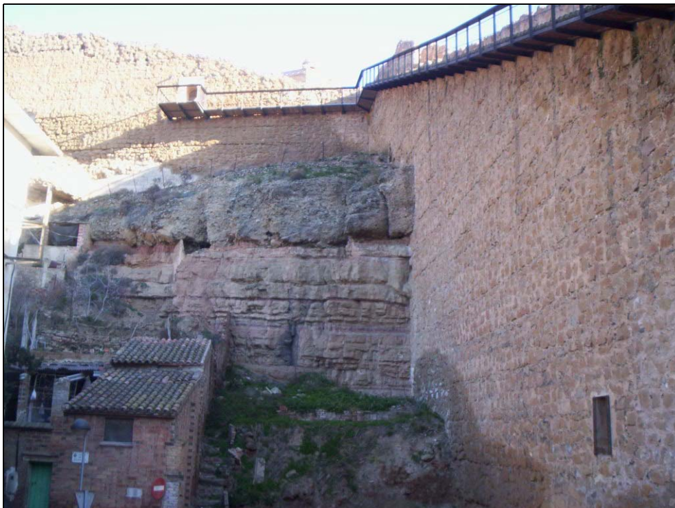
Fotografia D. Detall de la sèrie de materials típics de la zona on es realitza l'estudi. Graves/sorrenques/lutites.
