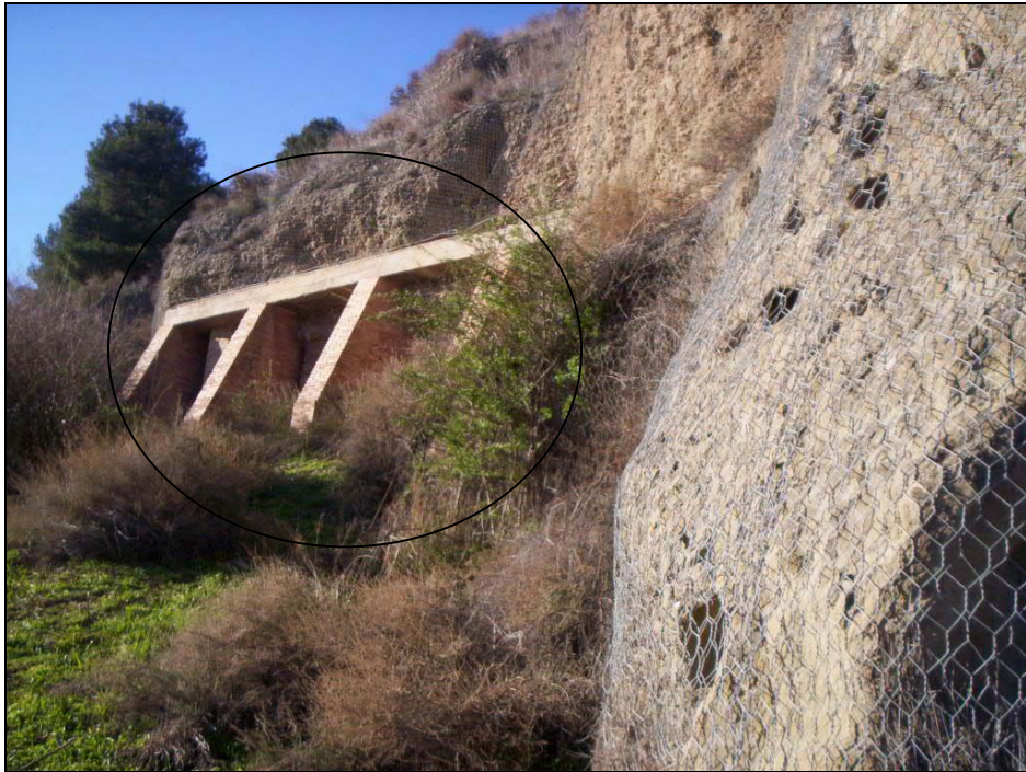
Fotografia 12. Exemple dels contraforts de totxos observats.
