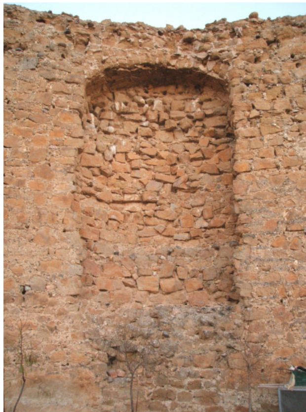
Imatge 8. Encaix d'una de les torres que defensaven la muralla. Es pot observar l'arc a la part superior.
