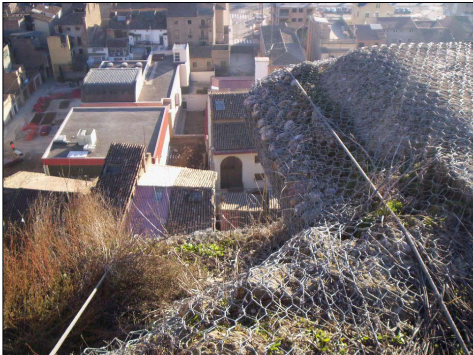
Fotografia 11. Exemple de la malla de triple torsió subjectada per cables d'acer.
