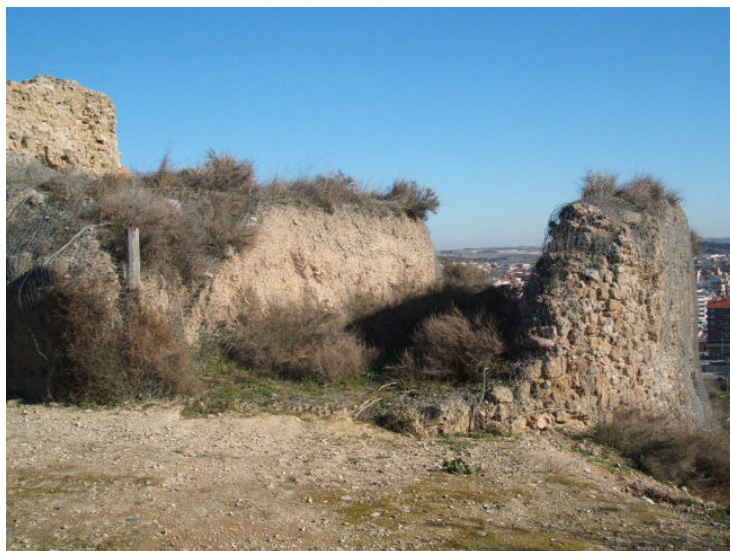
Imatge 9. La Torre Blanca després del buidat i del desmuntatge de part dels murs perimetrals.
