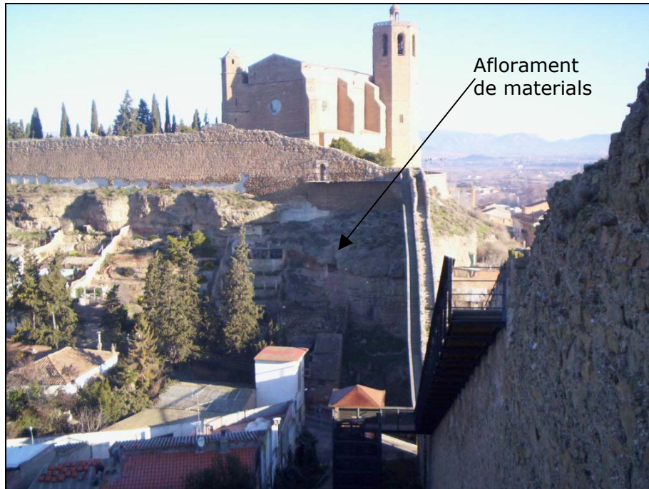
Fotografia 3. Extrem contrari de la muralla que connecta amb la muralla de l'església existent.
