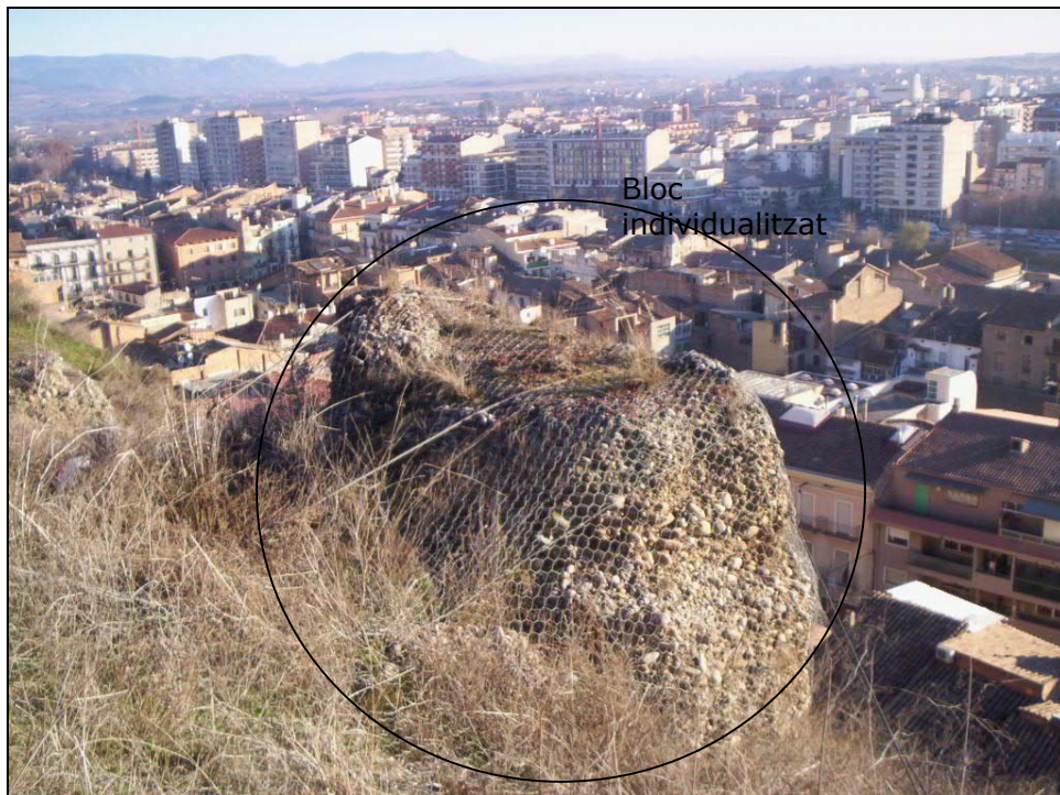
Fotografia 5. Exemple d'un bloc individualitzat possible candidat a caiguda per volcada.
